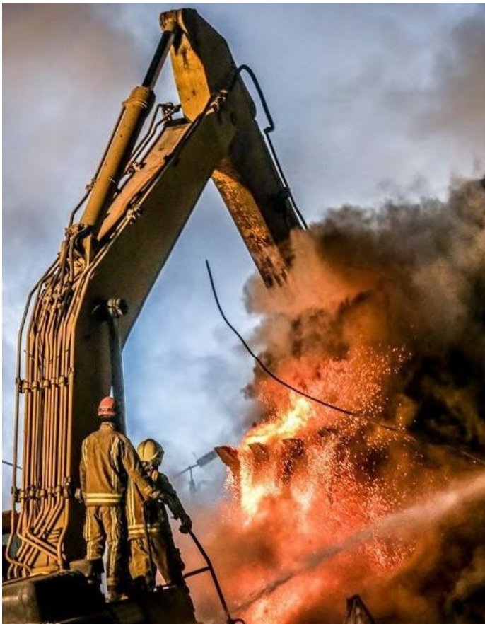
شکل 13: بیل مکانیکی در حال خارج کردن فلزات مذاب در صحنه ای از حادثه پلاسکو
